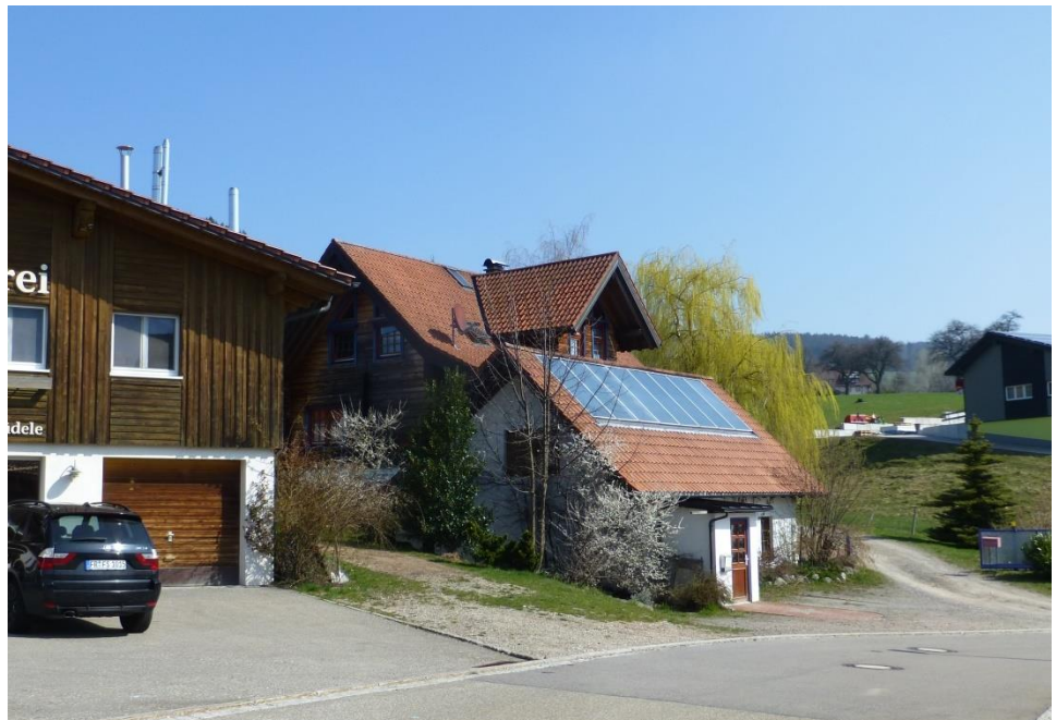
Abb. 3: Blick von Süden auf das Grundstück Nr. 632 (rechts) mit Betriebs- und Wohngebäude (bleibt bestehen)
