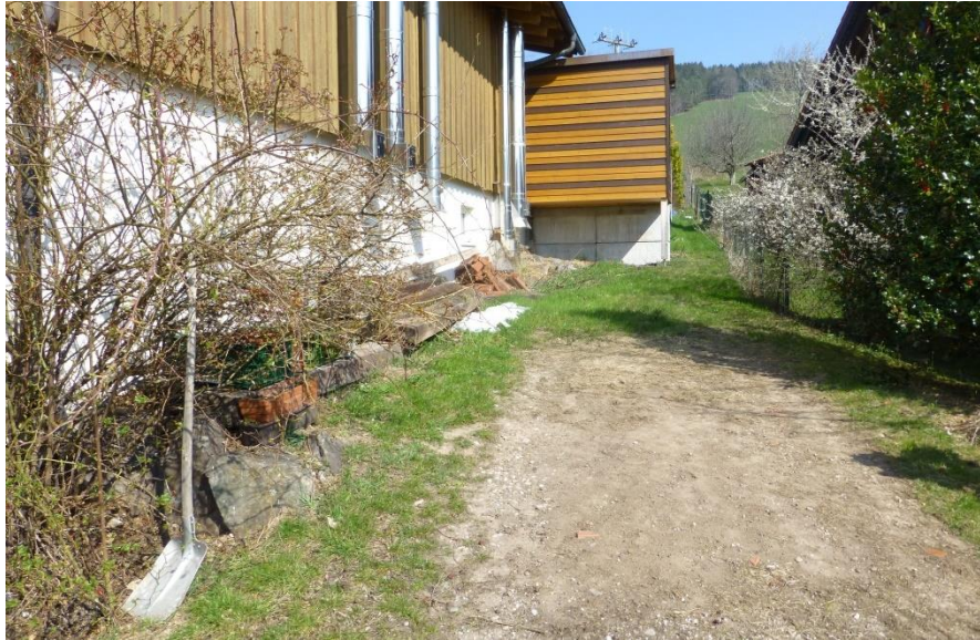
Abb. 6: Südostseite des Hauses, mit Steinen, Balken und Ziegeln
